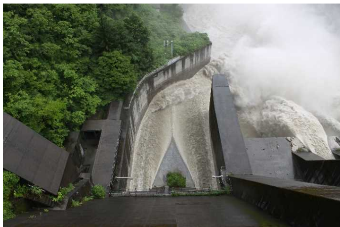
排砂ゲート開操作30分後 【7月13日15時00分】
