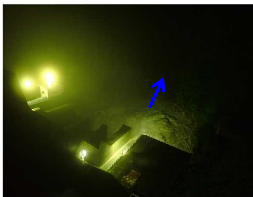
【出し平ダム下流】自然流下開始時(EL.306.34m) 7月13日 22:00撮影
