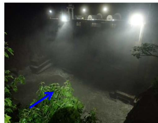
【出し平ダム排砂路呑口部】自然流下完了(EL.305.25m) 7月14日 01:00撮影
