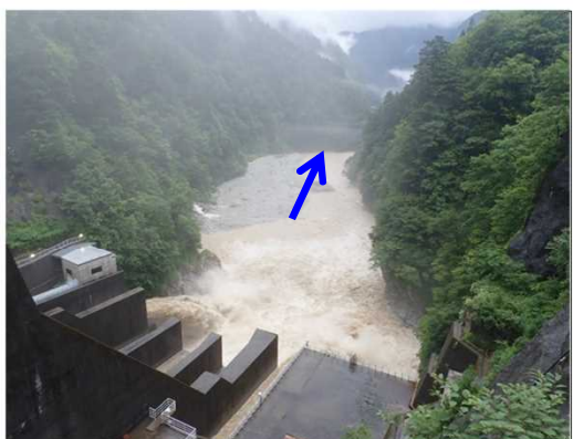
【出し平ダム下流】水位低下中(EL.316.55m) 7月13日 17:05撮影
