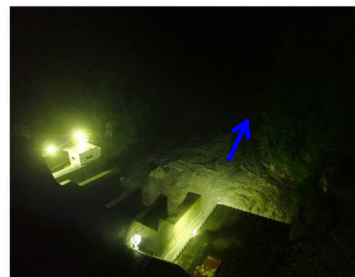
【出し平ダム下流】自然流下完了(EL.305.25m) 7月14日 01:00撮影
