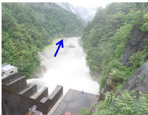
【出し平ダム下流】水位低下中(EL.316.00m) 7月1日 09:35撮影
