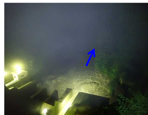
【出し平ダム下流】自然流下完了(EL.306.47m) 7月1日 23:30撮影
