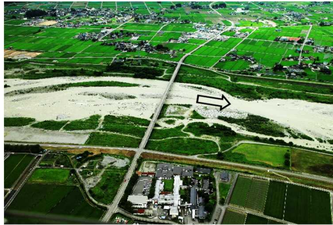
新川黒部橋(河口より9.6km)
