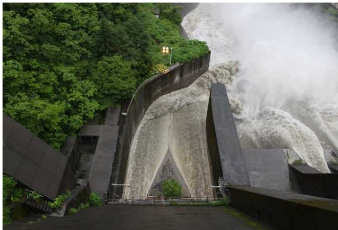
排砂ゲート開操作30分後 【7月1日6時00分】
