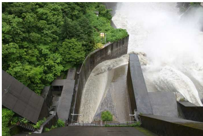
排砂ゲート開操作10分後 【7月1日5時40分】
