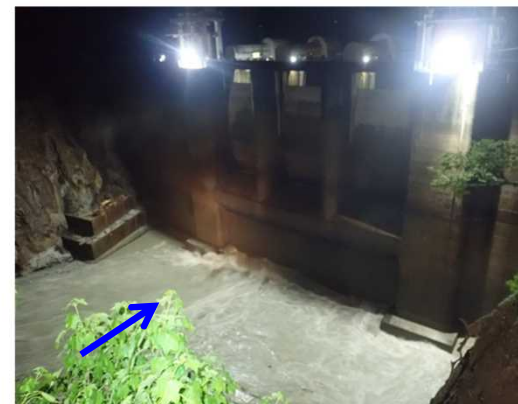
【出し平ダム排砂路呑口部】自然流下完了(EL.306.47m) 7月1日 23:30撮影
