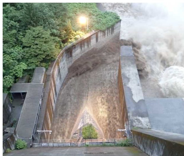
排砂ゲート開操作20分後 【8月21日5時30分】
