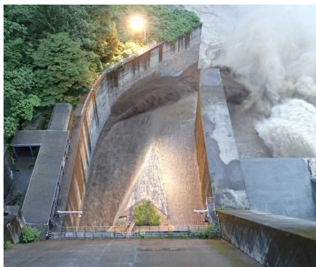
排砂ゲート開操作10分後 【8月21日5時20分】
