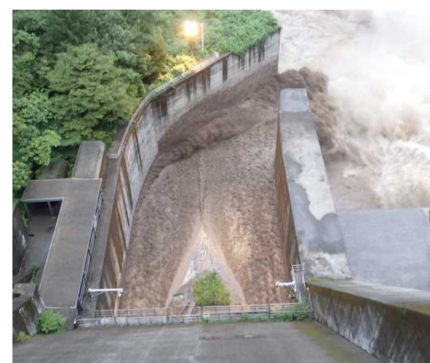
排砂ゲート開操作30分後 【8月21日5時40分】
