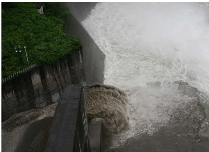
排砂ゲート開操作5分後 【9月1日14時55分】
