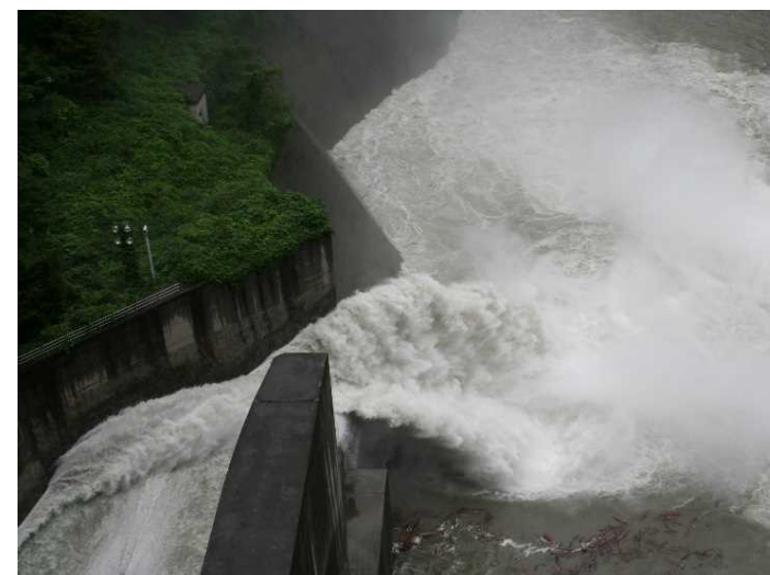
排砂ゲート開操作30分後 【9月1日15時20分】
