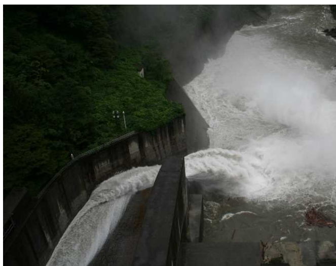
排砂ゲート開操作10分後 【9月1日15時00分】
