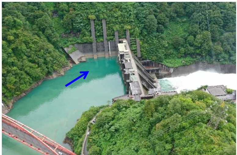
9月1日 13:00頃 撮影(対策前) 宇奈月ダム直下濁度 6度
