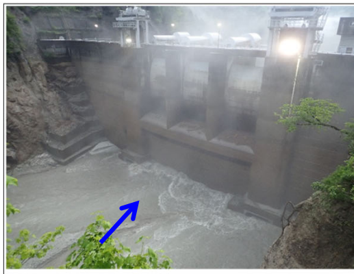
【出し平ダム排砂路呑口部】自然流下開始時(EL.305.10m) 7月6日 4:50撮影
