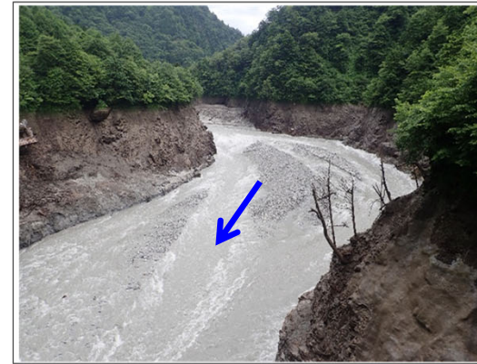
【出し平ダム湛水池】自然流下完了(EL.305.06m) 7月6日 13:00撮影
