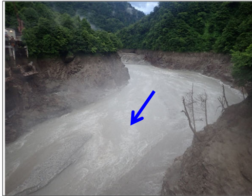
【出し平ダム湛水池】自然流下開始時(EL.305.10m) 7月6日 4:50撮影
