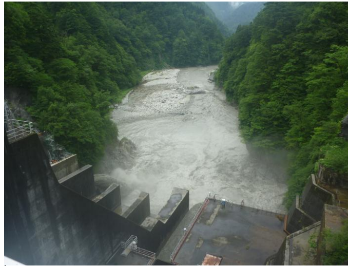
出し平ダム湛水池(13:15 水位低下中 貯水位:EL309. 0m付近)
