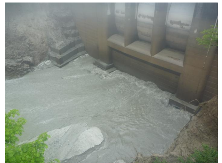
出し平ダム排砂路呑口部16:10 自然流下中)
