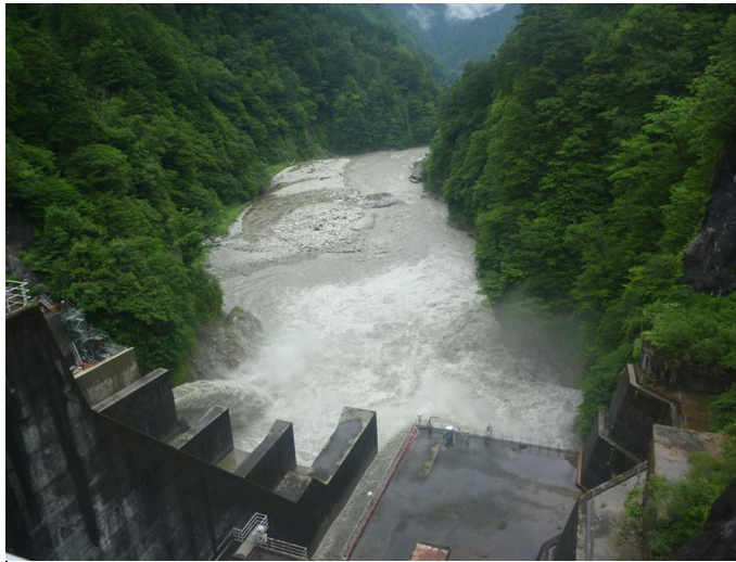
出し平ダム下流(12:25 水位低下中 貯水位:EL316. 0m付近)
