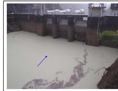
出し平ダム排砂路呑み口部(14時頃 水位回復中 3.0m付近)
