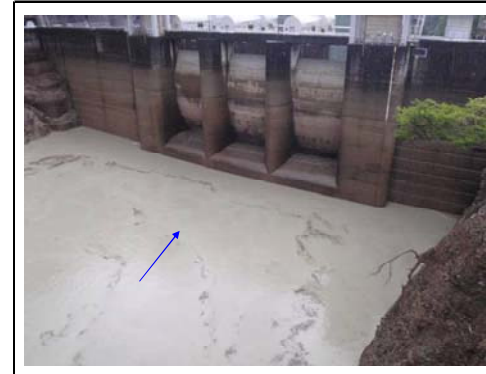
出し平ダム排砂路呑み口部(14時頃 水位回復中 3.0m付近)
