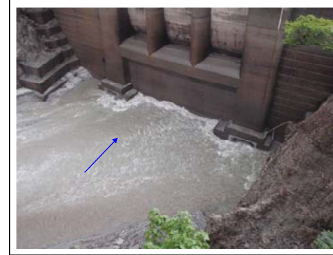
出し平ダム排砂路呑み口部(11時頃 水位回復中 -4.0m付近)
