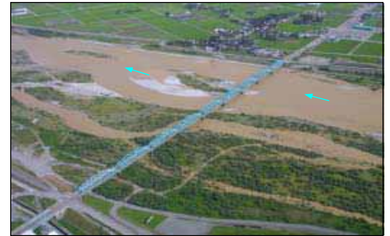
黒部大橋左岸側上流より右岸側下流部を望む。
