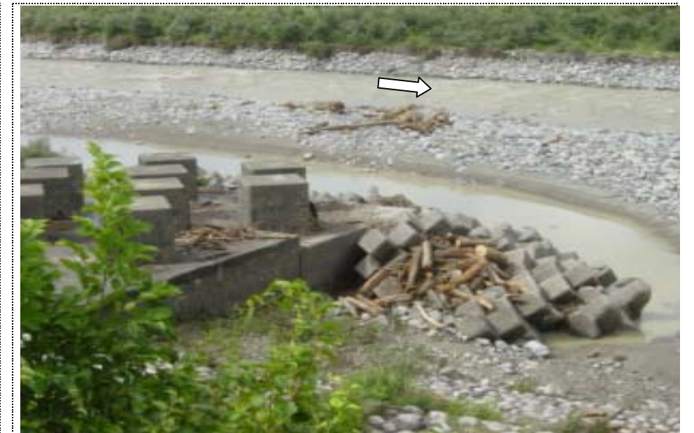
7月19日 15:04撮影 左岸下立地先(11.8km)水制
