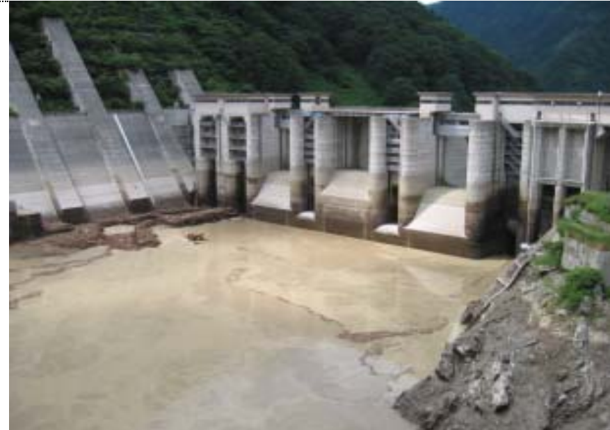
13:16撮影 宇奈月ダム背面状況
