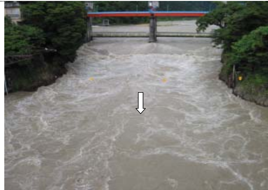
9:21撮影 愛本橋から上流愛本堰堤を望む
