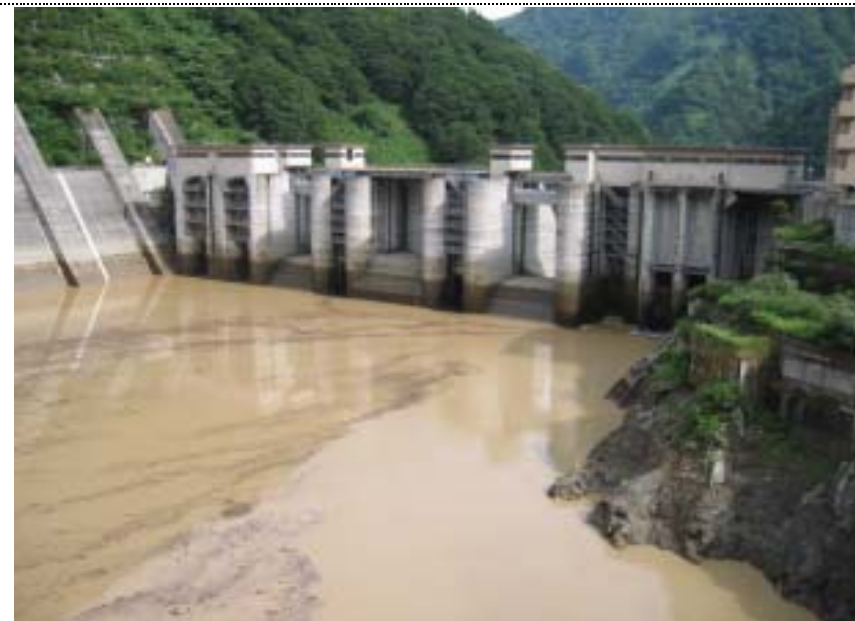
8:25撮影 宇奈月ダム背面状況
