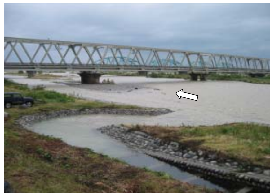
15:35撮影 飛騨魚道 高水敷から下流JR橋を望む
