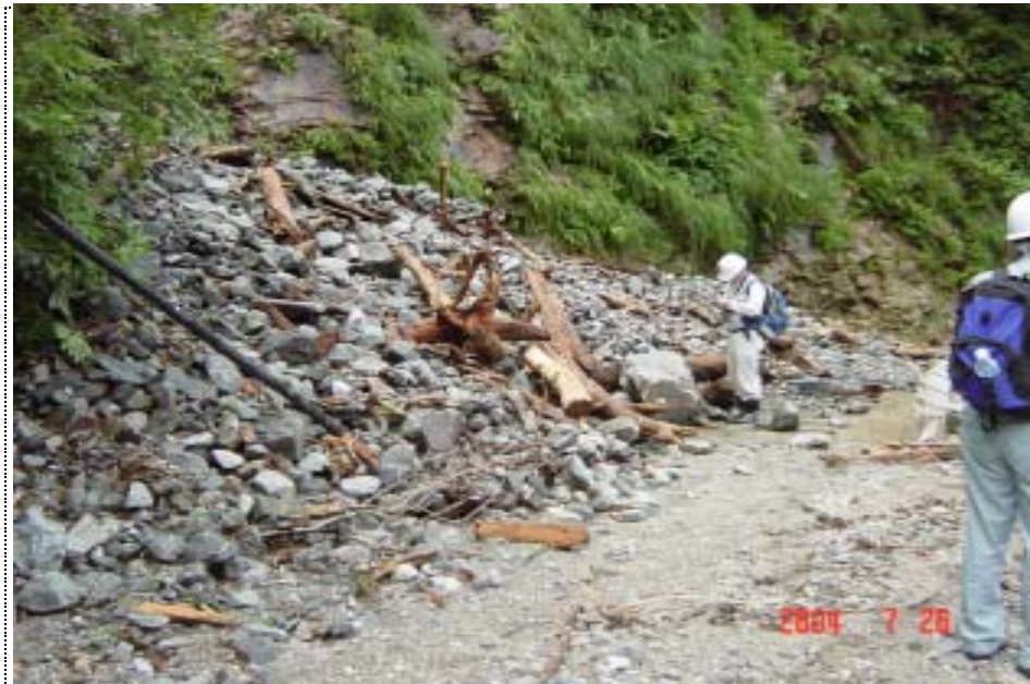
7月26日 撮影祖母谷工事用道路
