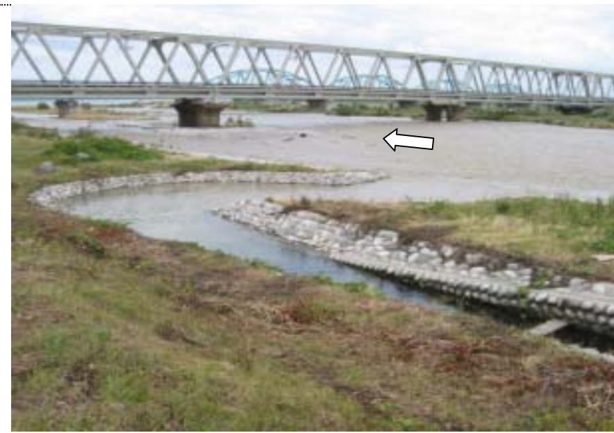
10:50撮影 飛騨魚道 高水敷から下流JR橋を望む
