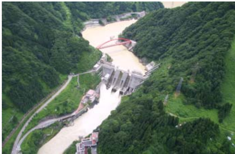
10:30撮影 ヘリ空撮宇奈月ダム貯水池の状況
