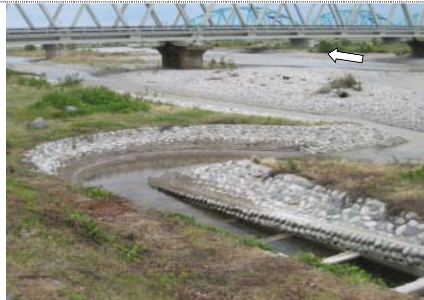
10:39撮影 飛騨魚道 高水敷から下流JR橋を望む
