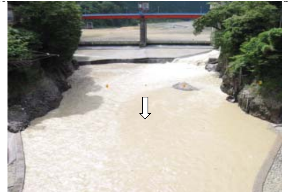
9:25撮影 愛本橋から上流愛本堰堤を望む
