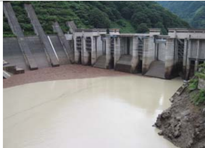
8:53撮影 宇奈月ダム背面状況
