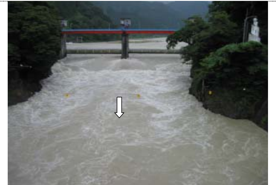
14:26撮影 愛本橋から上流愛本堰堤を望む
