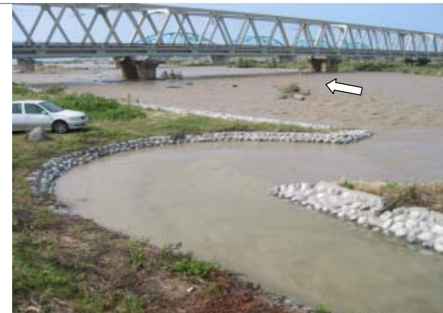
15:08撮影 飛騨魚道 高水敷から下流JR橋を望む
