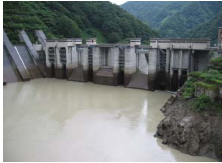
13:59撮影 宇奈月ダム背面状況
