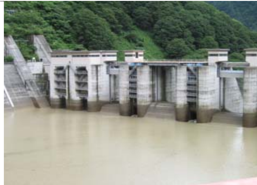
8:48撮影 宇奈月ダム背面状況
