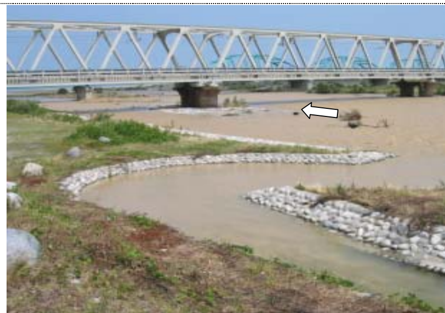
10:18撮影 飛騨魚道 高水敷から下流JR橋を望む
