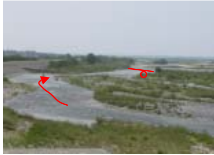
2.四十八ヶ瀬橋 遠景
