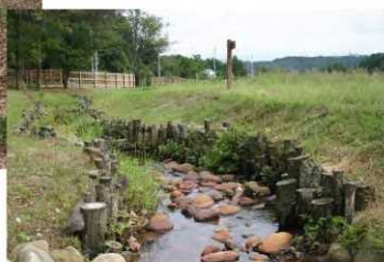
水生生物の生息環境を保全する多自然川づくり
