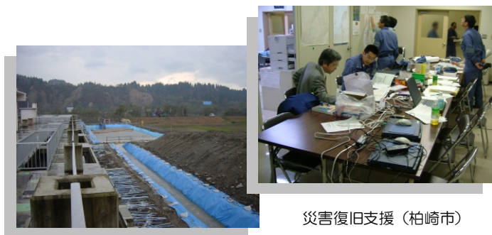
仮設沈殿池による簡易処理 （新潟県魚野川流域下水道）
