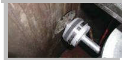
既設人孔の耐震化施工例
