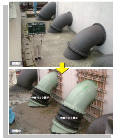
ポンプ場の地震対策（金沢市）
