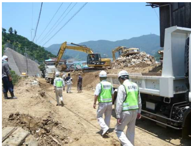
(一社)愛媛県建設業協会
