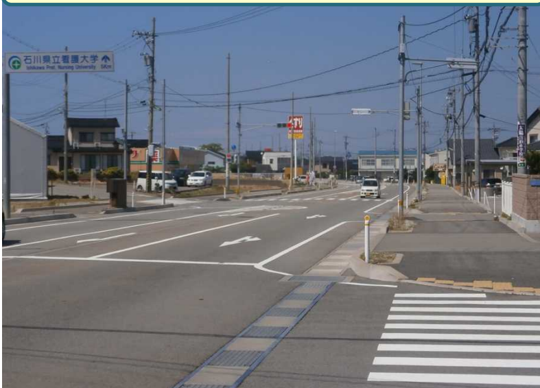
木津・松浜地内歩道整備
