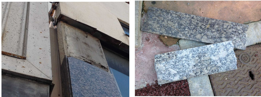
外壁材の剥離・落下
