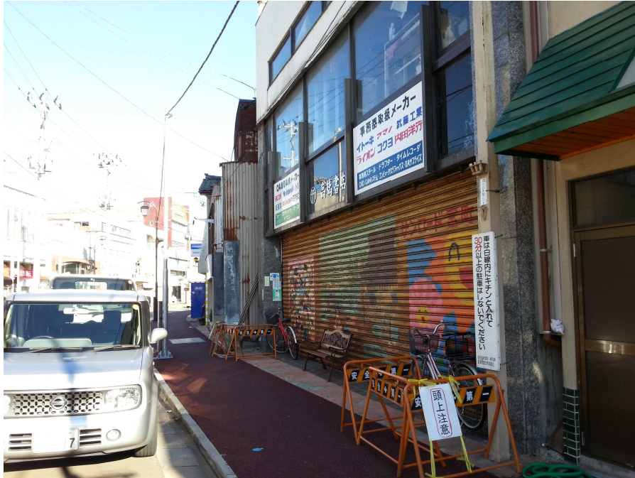
旧書店(鉄骨造3階建て)
