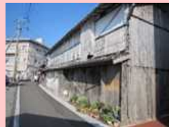
空き家の除却
