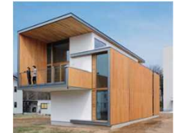
CLT工法による実験棟
