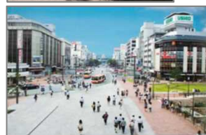
駅前のトランジットモール化と広場創出（兵庫県姫路市）
