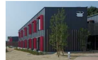
CLT工法による木造ホテル
