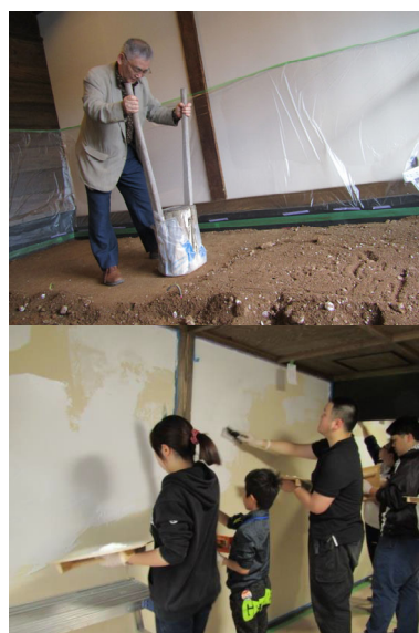
▲市民や学生の参画によるワークショップの様子（上段：土間の整備、下段：漆喰塗り）
