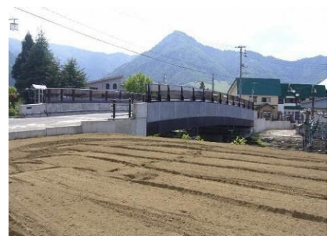
整備後跨線橋
