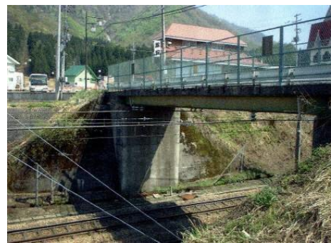
整備前跨線橋
