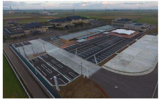
道の駅等完成
