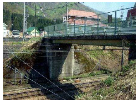
整備前跨線橋
