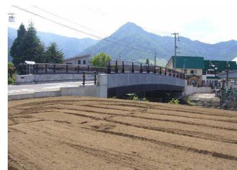
整備後跨線橋
