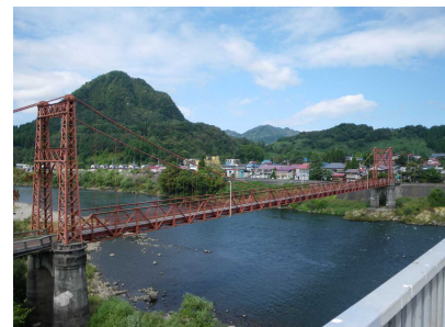
町道鹿瀬線（鹿瀬橋）整備前
