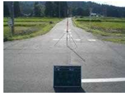
町道堂ノ下ノ上線 整備前
