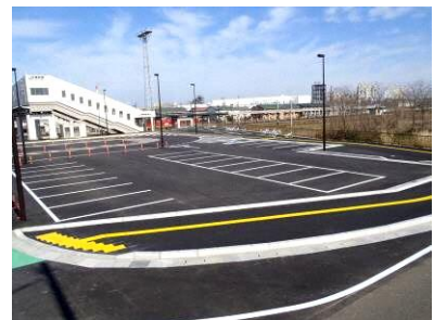
▲ 整備後の南口広場
