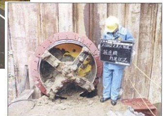
▲雨水排水管施工時
