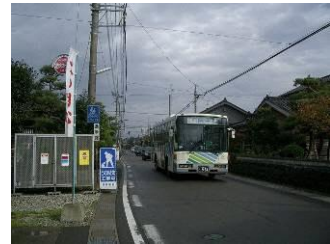
▲歩道がない地区の幹線道路
