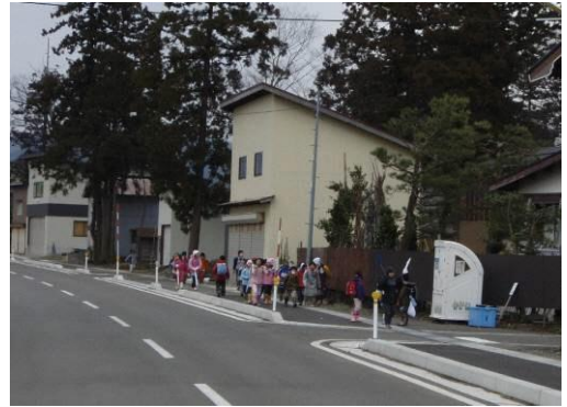
▲整備後の市道水科線
