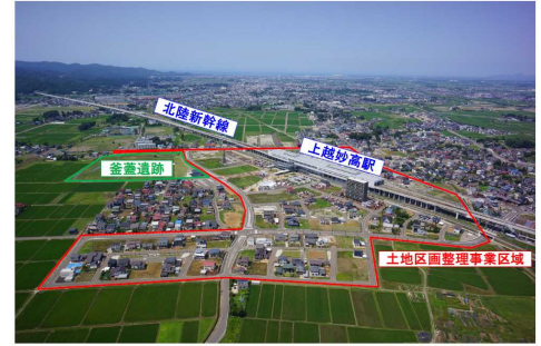
▲北陸新幹線上越妙高駅建設 完了
