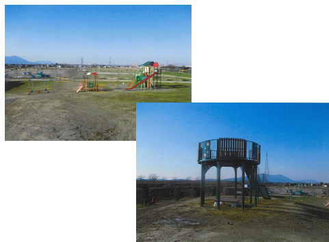
▲大河津分水さくら公園遊具整備状況
