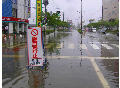
▲雨で浸水被害が発生し通行止めとなる
