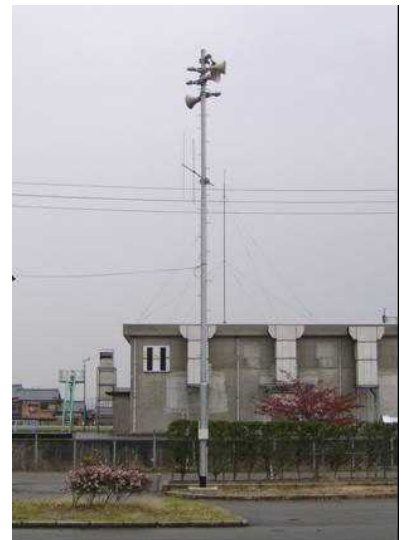
▲屋外拡張子局設置及び既存設備のデジタル化
