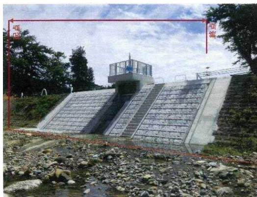
浸水対策事業、バイパス排水路の吐口
