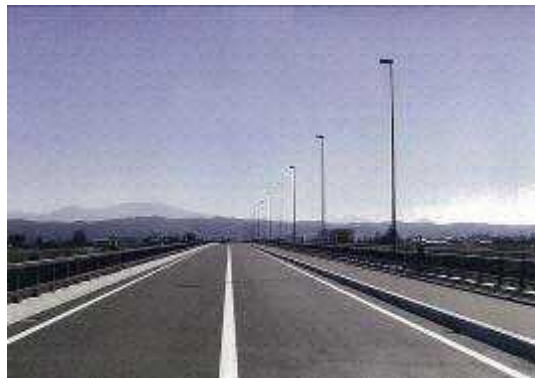
加茂大橋施工状況
