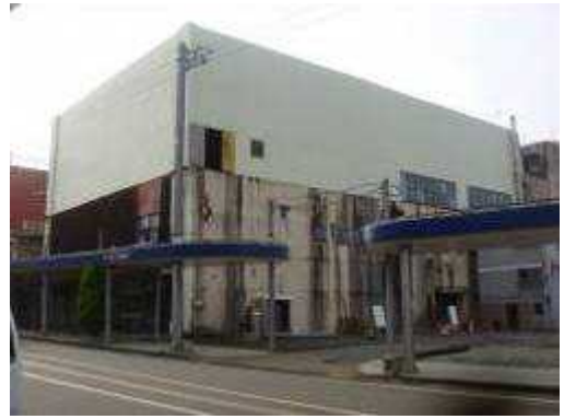
▲ 中心市街地に点在する放置空き店舗
