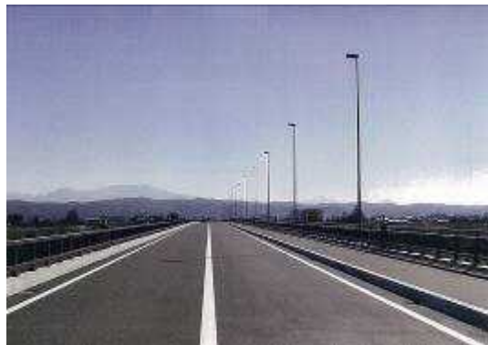
加茂大橋施工状況
