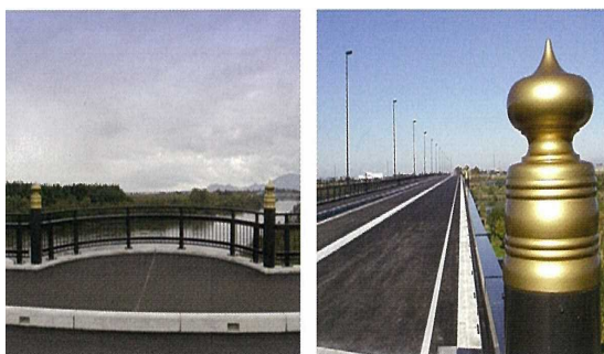
親柱、中間柱、高欄のグレードアップ及びバルコニーの設置（市負担）施工状況
