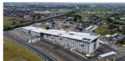
整備後の外観
