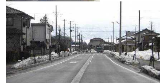
▲ 中環状道路 西新発田五十公野線（緑町工区）の整備前と整備後の状況
