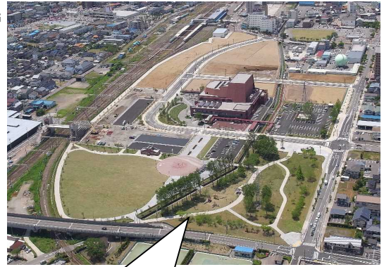
整備が完了した柏崎駅前 土地区画整理事業地の状況
