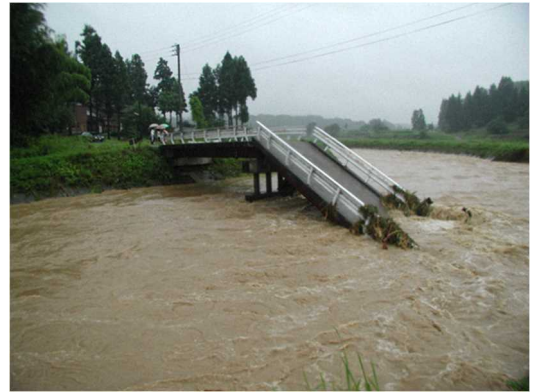
▲ 濁流により落橋した栄雲寺橋
