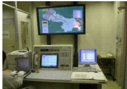
▲ 整備された防災通信施設
