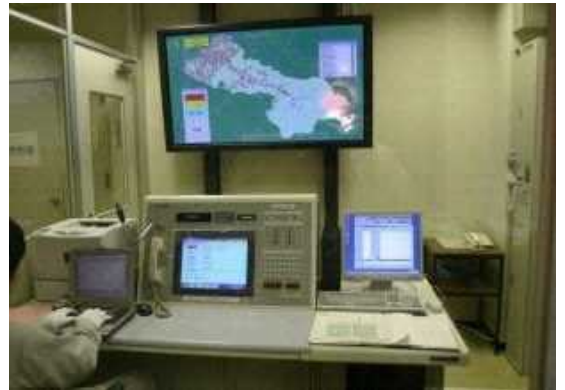
▲ 整備された防災通信施設
