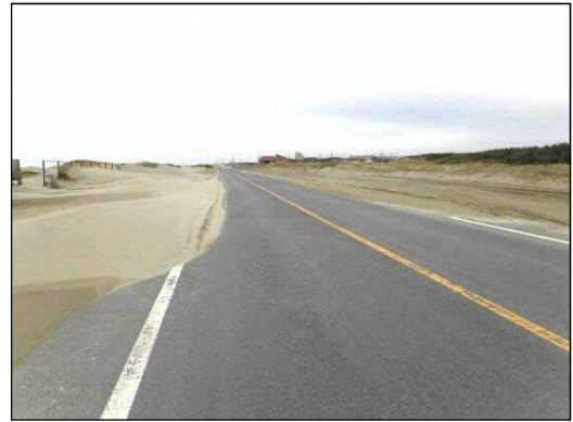
一般国道402号 堆砂状況
