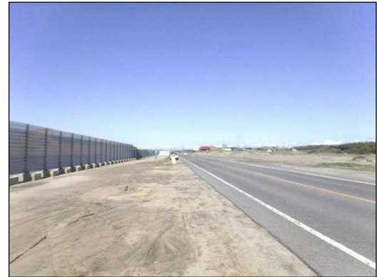
一般国道402号 飛砂対策状況
