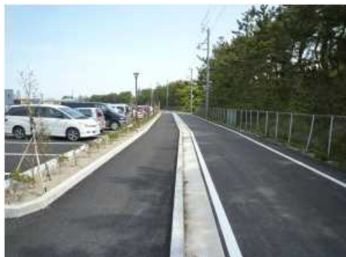
・路上駐車状況（整備後）
