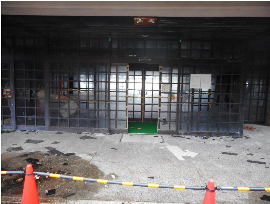
南側正面玄関状況
