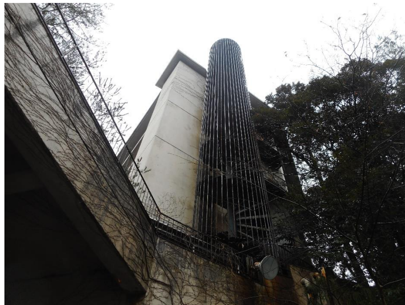
螺旋階段腐食狀況
