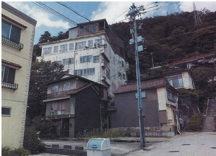
全景写真 (解体前)
