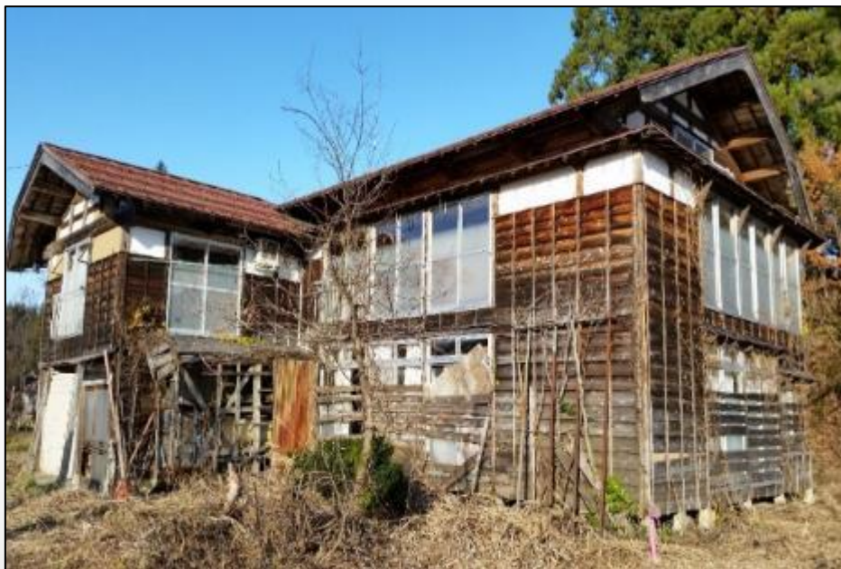
改修前の空き家
