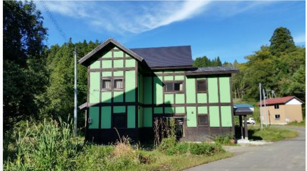
改修後の竹所体験宿泊施設
