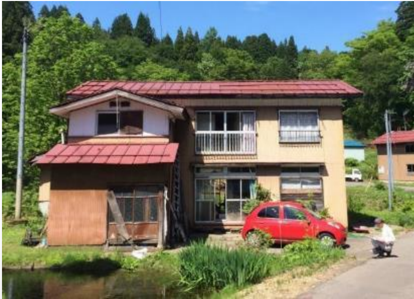
改修前の空き家
