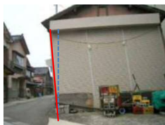
ランク3 (傾きはあるが、大規模修繕をすれば、再利用可能)
