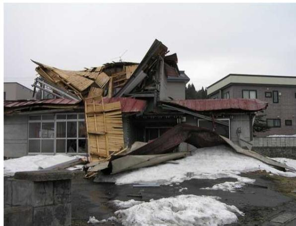
**積雪により屋根が落下した空き家**
