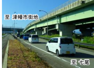
① 国道159号側道(下り)
