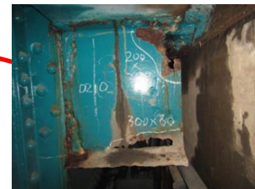
橋桁の補修(路面より下)
