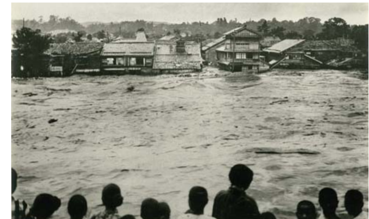
犀川大橋の上流側状況
