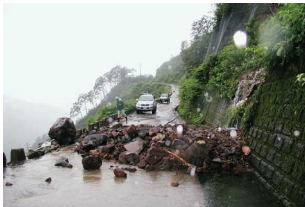
甚之助資材運搬道路土砂崩落
