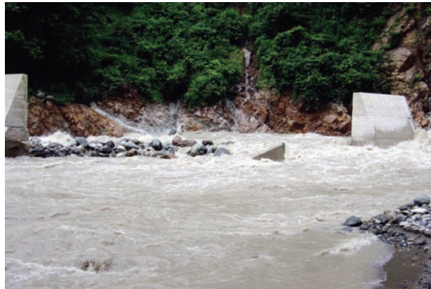
尾添第2号工事用道路仮橋流出
