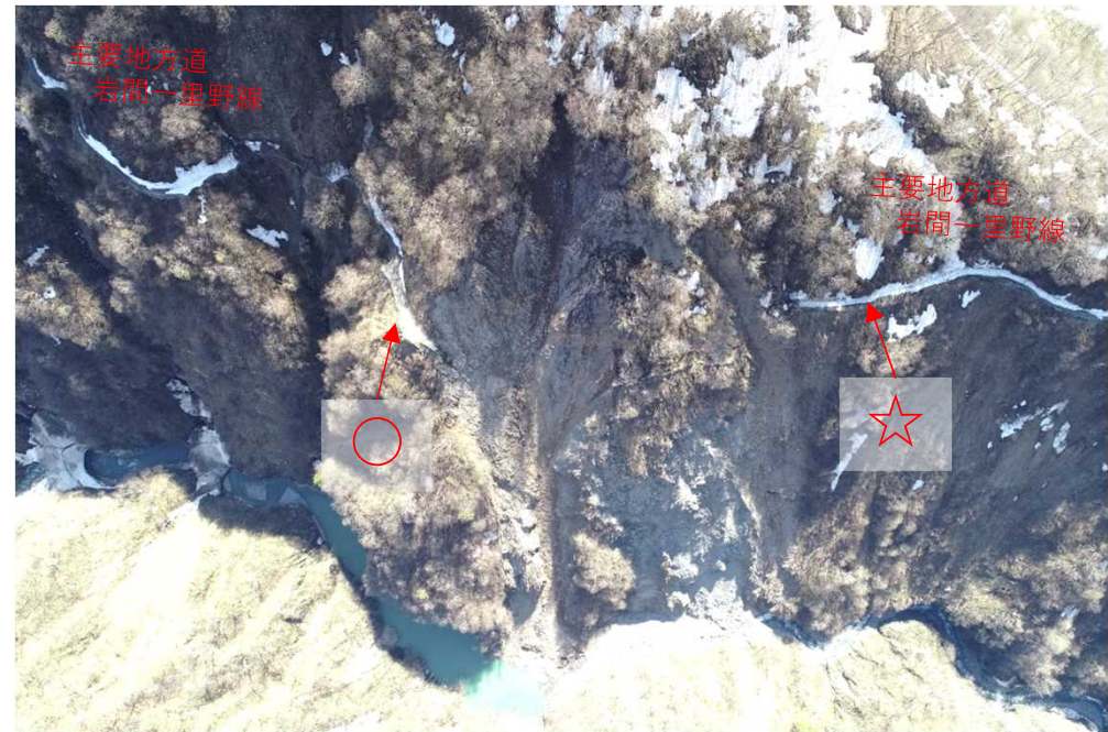
中ノ川崩壊後 上空写真 [R3.4.15撮影]
