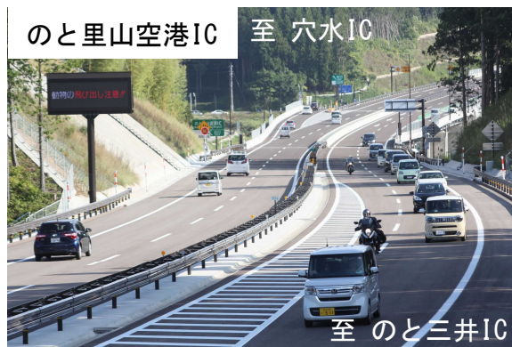
《開通後の状況》
